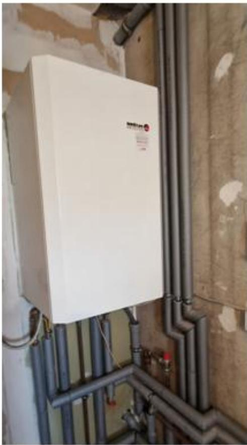
Der Warmwasserspeicher mit 300 ltr. Fassungsvermögen wird über die Solaranlage (4 m<sup>2</sup> Fläche) auf dem Dach beheizt.
